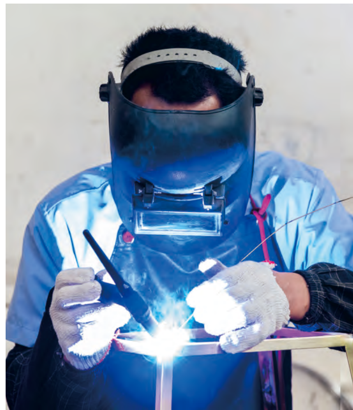
WELD 电气焊接
